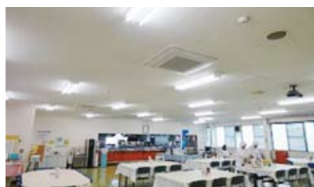
▲食堂も兼ねるホールには電力消費量の少ないLED蛍光灯を導入
