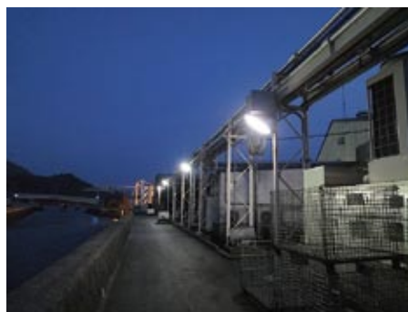
▲常夜灯をLED照明に交換しました。
